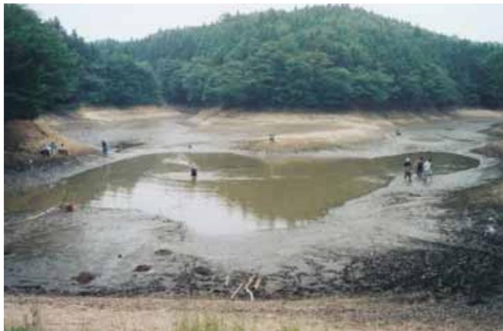
図8 エンジンポンプによる排水(2002年9月鹿島台町) 排水栓を抜いても完全排水できない時はエンジンポンプで排水する。
