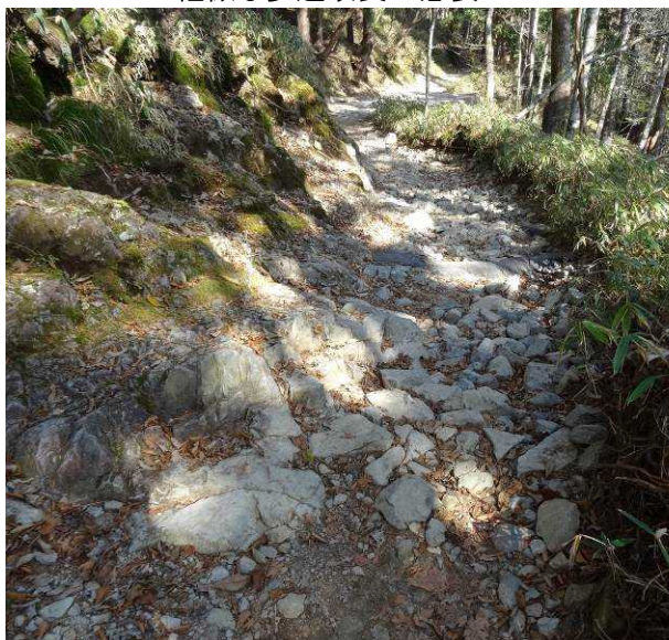
図 6-11 No.10 歩道上に岩が露出し、段差が生じている 軽微な歩道改良が必要
