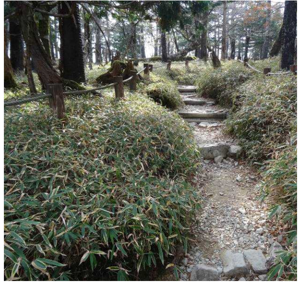
図 6-30 No.29 階段歩道が続く箇所
