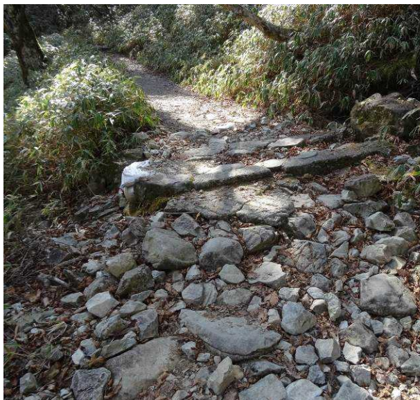
図 6-9 No.8 歩道改良で布設された石が動いて段差が生じている 軽微な歩道改良が必要
