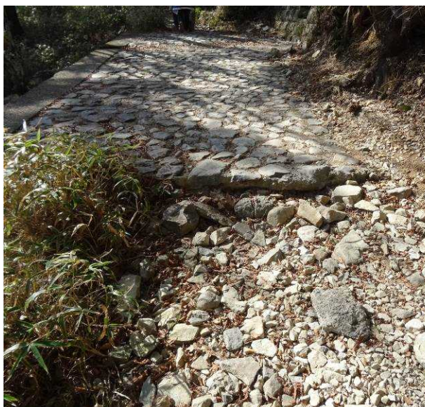
図 6-13 No.12 コンクリートの歩道と土の歩道の上に段差(5~ 10cm)がある 不整地運搬車の通行に問題なし
