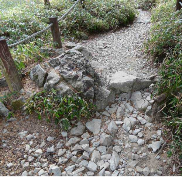
図 6-29 No.28 20~30m程度の段差 歩道巾狭く、不整地運搬車通行不可
