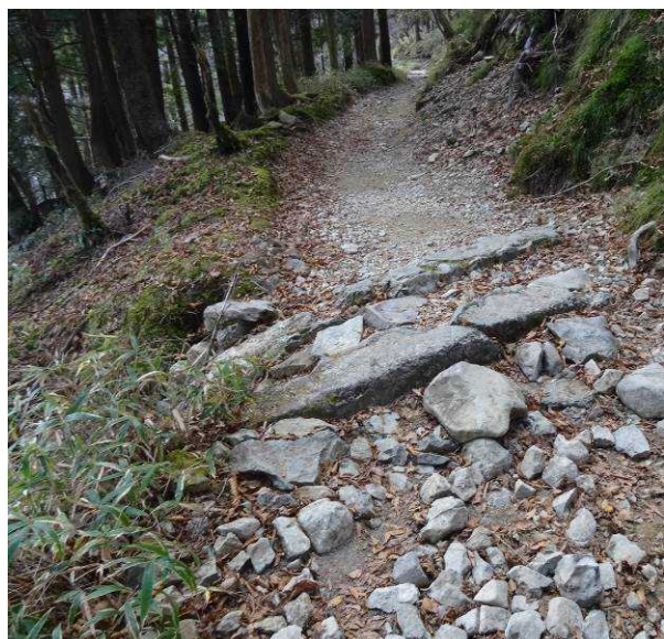
図 6-14 No.13 小さな段差 不整地運搬車の通行に問題なし
