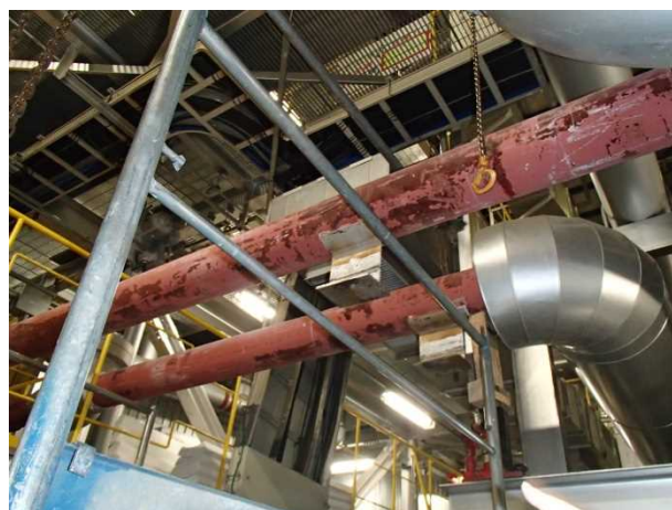
吹田市（配管脱落）
