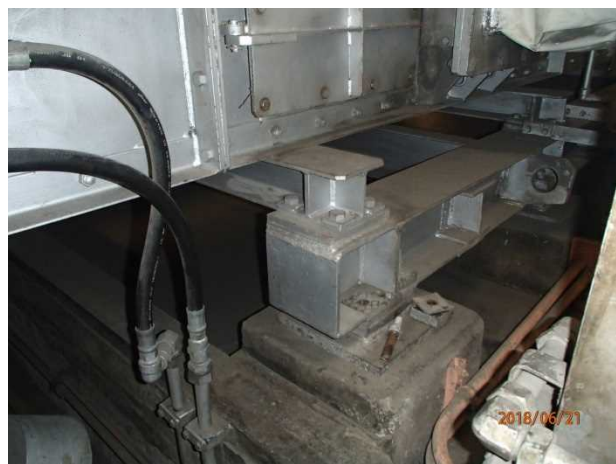
箕面市（ボルト破損）
