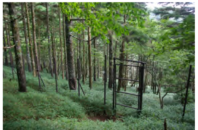
FRP 製支柱とステンレス入ネット柵(No17、上道)
