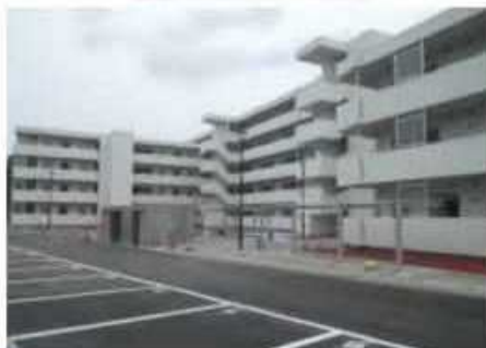
霊屋下第二 (H27.9月完成)
