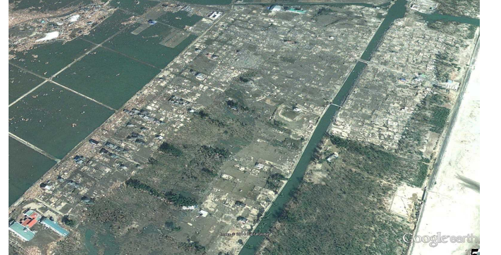
若林区荒浜地区 震災後2011.03.14
