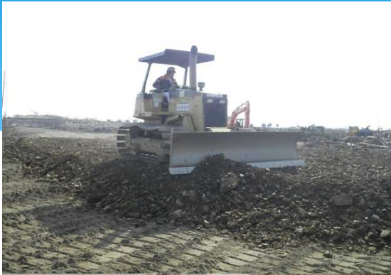
井土がれき搬入場造成隊 造成状況
