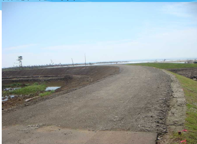
暫定復旧完了写真
