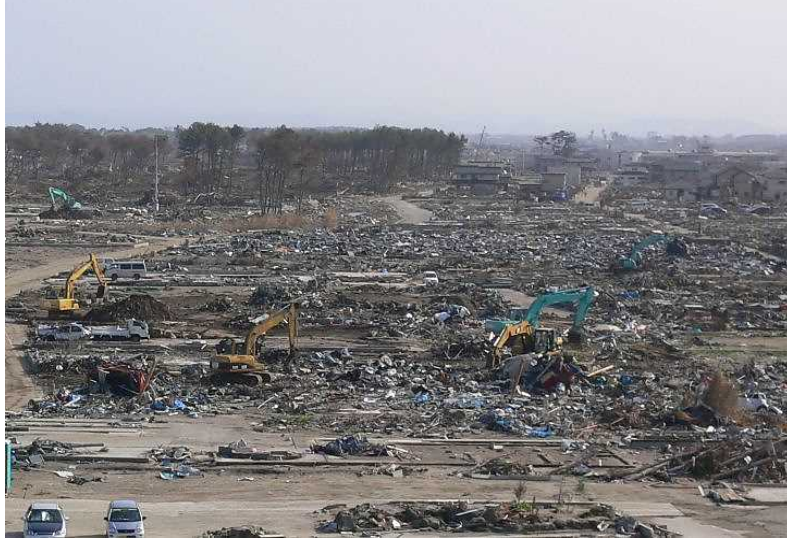
宅地がれき撤去隊 第3班 荒浜地区
