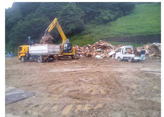
可燃物の搬出状況(7/12)
