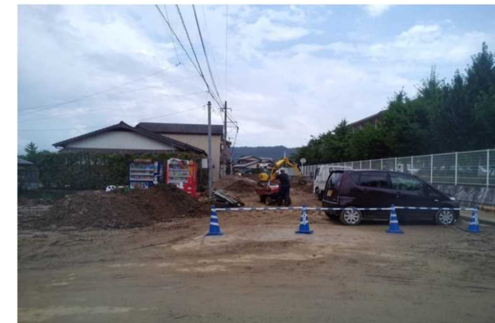
土砂の堆積による道路の寸断 (朝倉市杷木中学校前 7/8)
