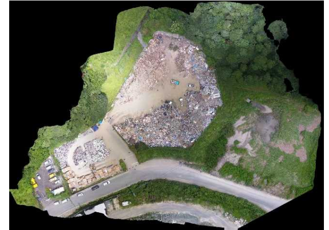
ドローンによる仮置場空撮画像 (7/16)
