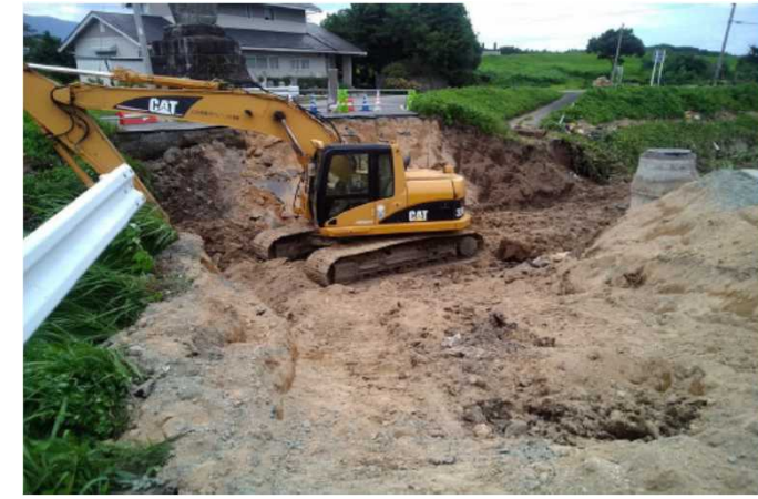
道路盛土の土砂流出 (朝倉市甘木地区長田 7/11)
