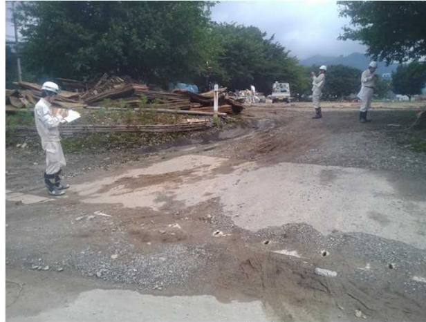
自主仮置場の仮置状況確認 (朝倉市荷原地区自主仮置場 7/12)
