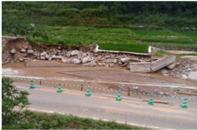
道路片側の崩落 (東峰村鼓の里付近 7/11)
