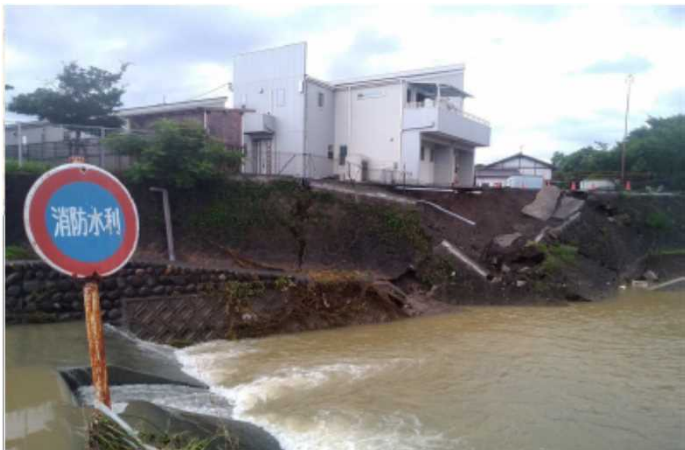
河川護岸の崩壊 (朝倉市朝倉地区 7/8)
