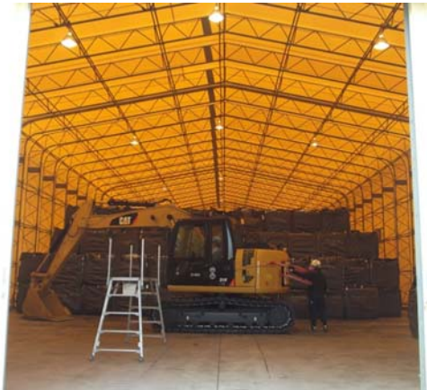
仮設灰保管施設の内部
