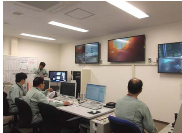
管理棟1階( )の中央制御室
