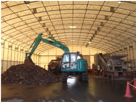
瓦・レンガ類、陶器・タイル類の破碎・分別作業
