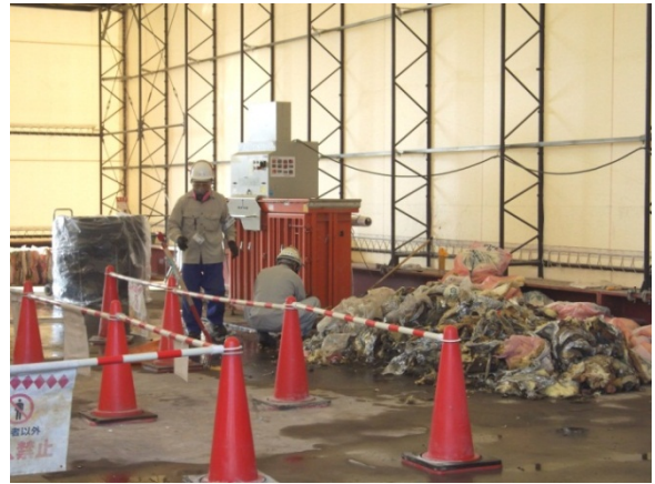
断熱材類の圧縮減容作業
