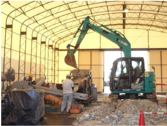
内壁材（石膏ボード）の破碎・分別作業
