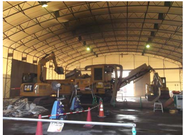
外壁材の破碎・分別作業
