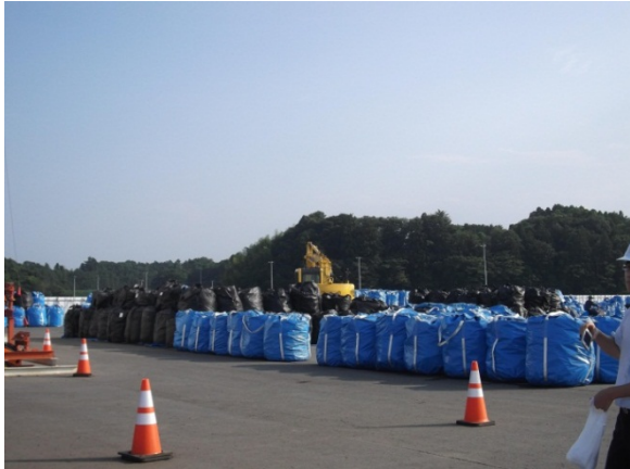
梱包した災害廃棄物の置場
