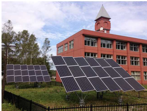
避難所に設置した太陽光発電
