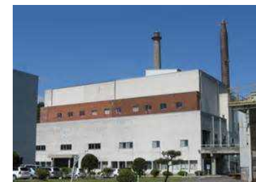
【ごみ焼却施設】
