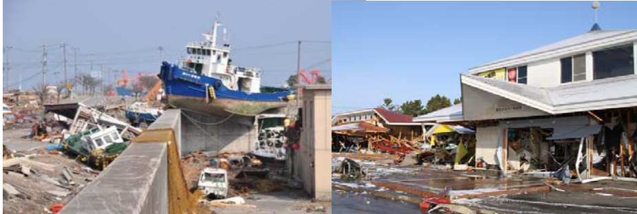
防潮堤に乗り上げた船舶(左:久慈市提供)と被災した物産施設(右:洋野町提供)
